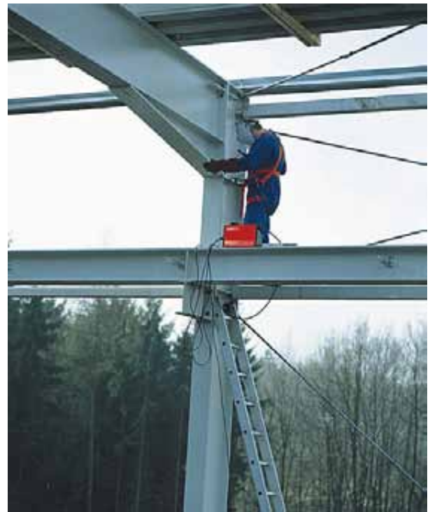
Bild 20 Einsatz der Inverter-Schweißstromquelle PICO 162 auf der Baustelle
