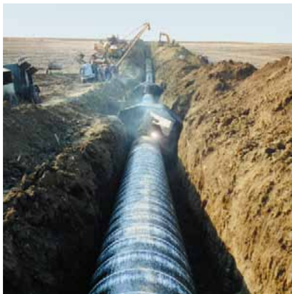
Bild 6 Schweißen im Rohrleitungsbau mit Zelloseelektroden
